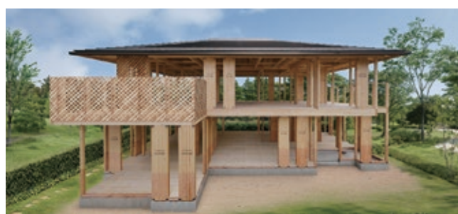
ビッグフレーム構法の構造躯体
